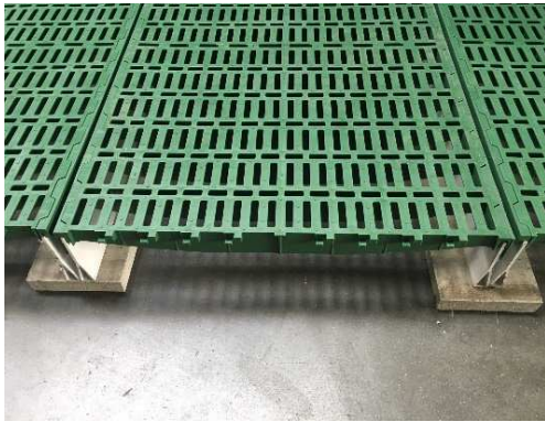
Abb. 10, 11 Dieses Segment kann nun unabhängig von der restlichen Fläche herausgehoben werden.
