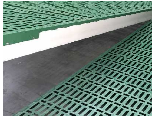
Abb. 10, 11 Dieses Segment kann nun unabhängig von der restlichen Fläche herausgehoben werden.
