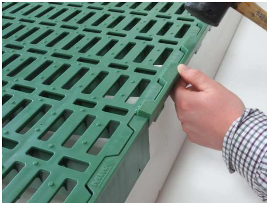
Abb. 4 Randleiste zwischen den LOS-Leisten aufsetzen .....
