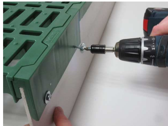
Abb. 7 .....bis an die Halteleiste andrehen.
