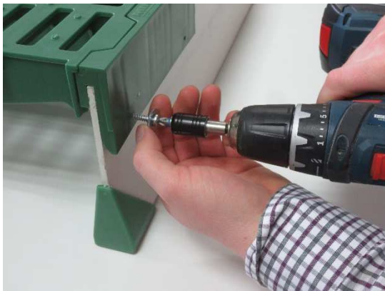
Abb. 6 Selbstschneidende Schrauben ohne Vorbohren .....
